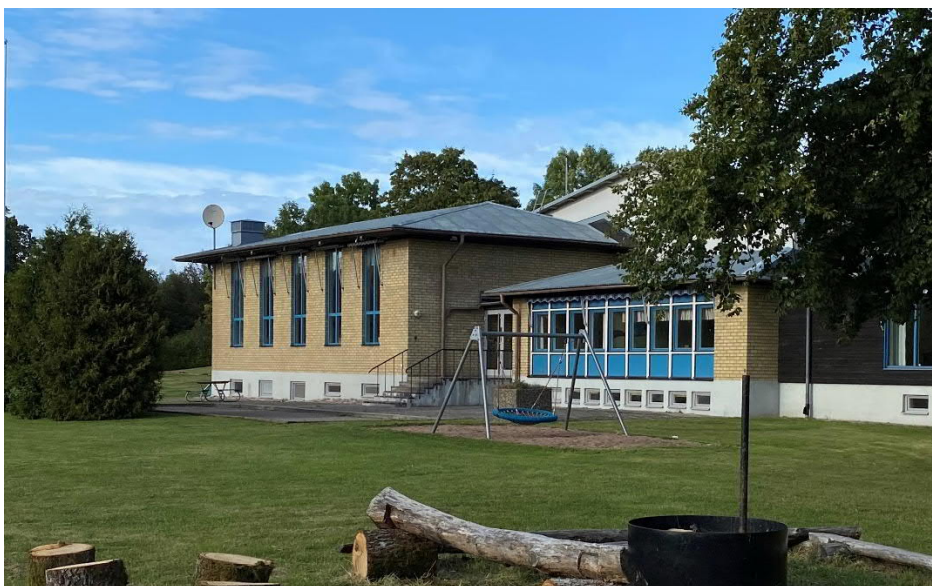
Foto som visar soldathemmets västra fasad vilken skyddas från förändring i planen.
